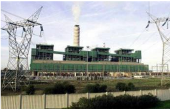
Centrale a carbone pulito Brindisi
